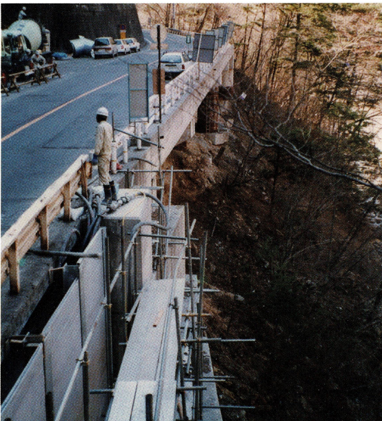
長野県橋梁整備大白川2号橋
